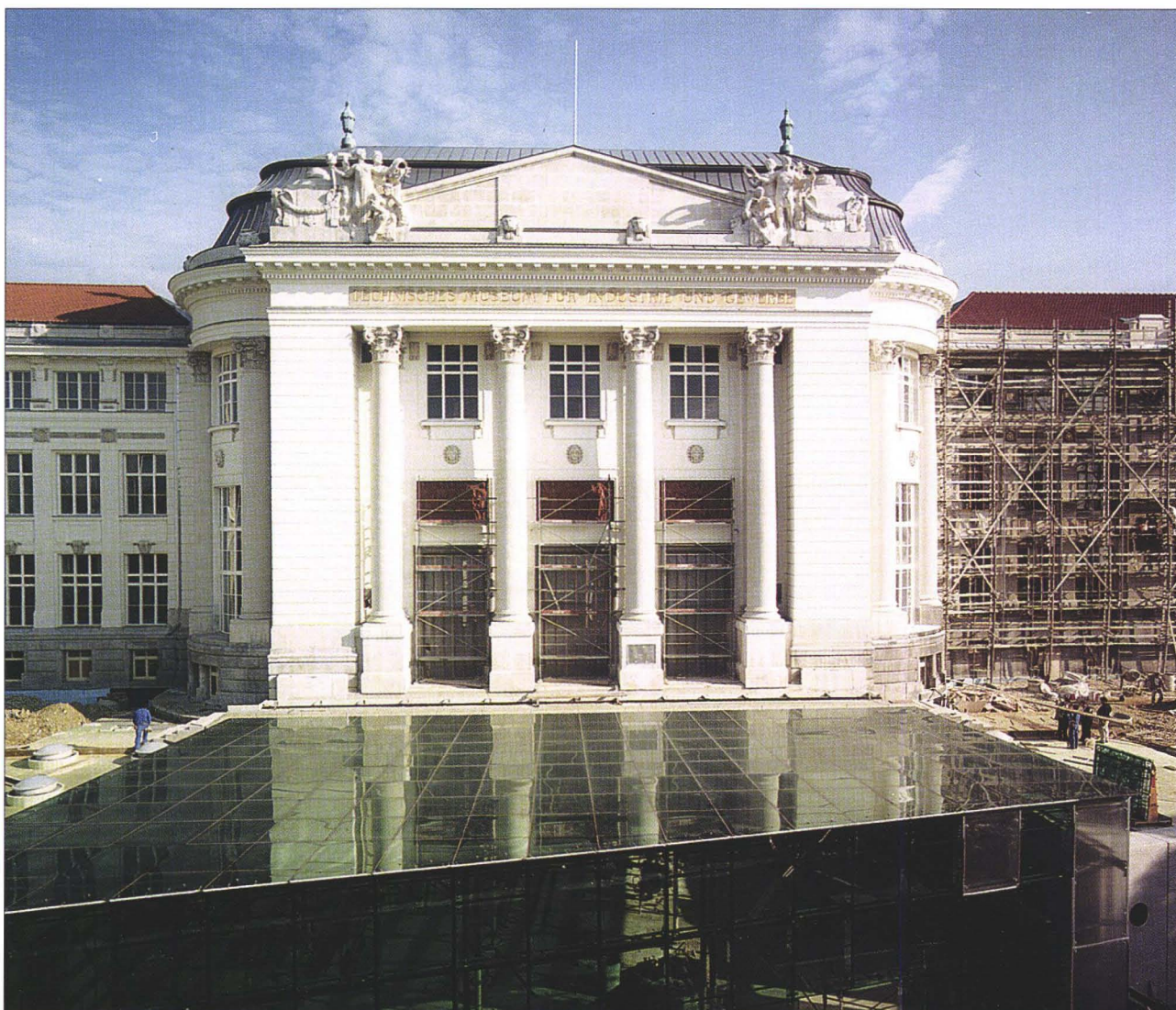
Mittelrisalit mit noch im Bau befindlicher neuer Eingangshalle, Oktober 1996
