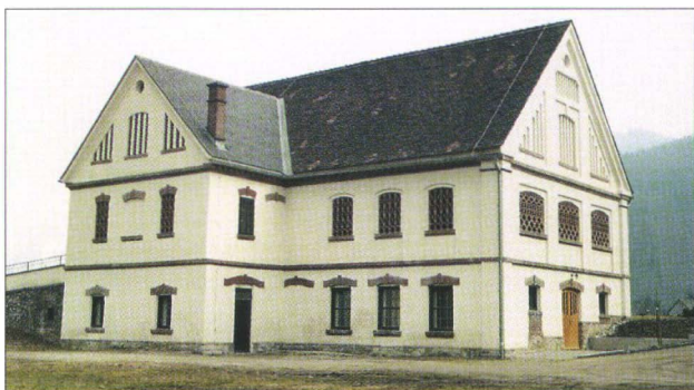
Zellach, ehem. Wirtschaftsgebäude
