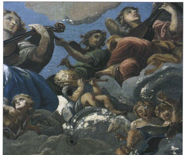
Wien I., Pfarrkirche St. Peter. Hauptkuppel, Details vor Restaurierung
