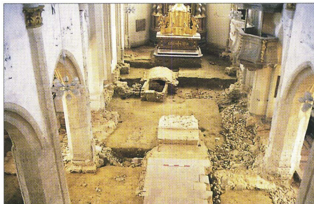
Aspach, OÖ, Kirche, Fundamente des römischen Vorgängerbaues
