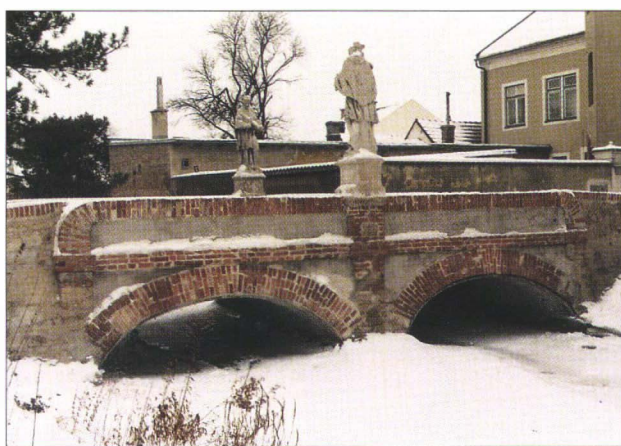
Achau, Brücke über den Neubach
