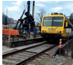
Die Montafonerbahn (mbs) investiert derzeit acht Millionen Euro für noch mehr Qualität auf der Bahnlinie zwischen Schruns und Bludenz. (Foto: Montafonerbahn AG; Trassenneubau Lorüns-Alfenzbrücke)
