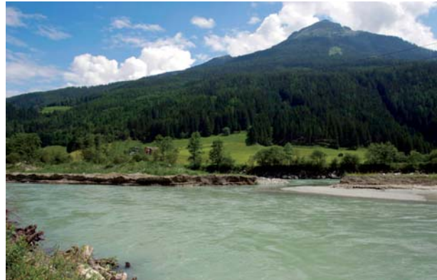
Hochwasserschutz Salzach Bramberg
