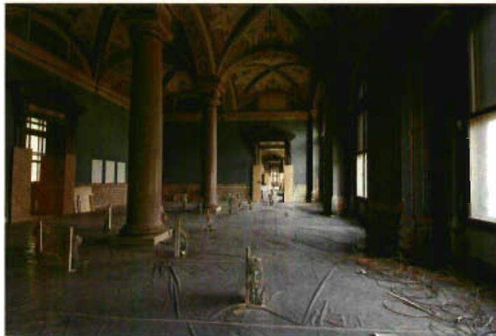
Kunstkammer, Baustelle © KHM
