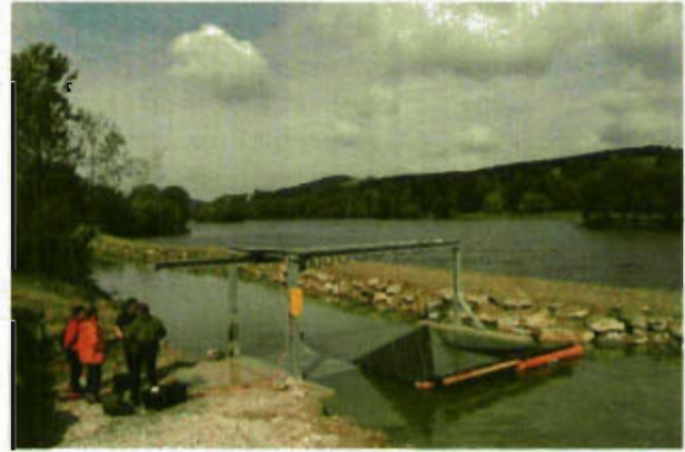
Fischaufstiegshilfe beim Kraftwerk Melk - Funktionskontrolle
