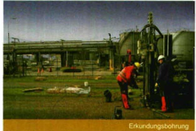
Die in die Priorität 3 eingestufte Altlast wird nun von der ELG-Asset GmbH durch Räumung in der ungesättigten Zone, Abschöpfung der aufschwimmenden Mineralölphase am Grundwasser und Airsparging (Einblasen von Luft in das Grundwasser) vollständig saniert. Das kontaminierte Bodenmaterial wird nach Voruntersuchungen auf dem Stand der Technik entsprechenden Deponien ordnungsgemäß entsorgt. Das im Zuge der Arbeiten entnommene Grundwasser wird über eine Aktivkohlereinigungsanlage dekontaminiert.
