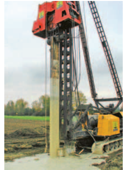
Herstellung Dichtwand
