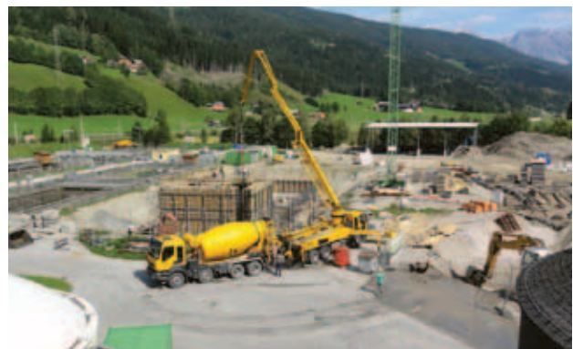
Betonierarbeiten am Belebungsbecken
